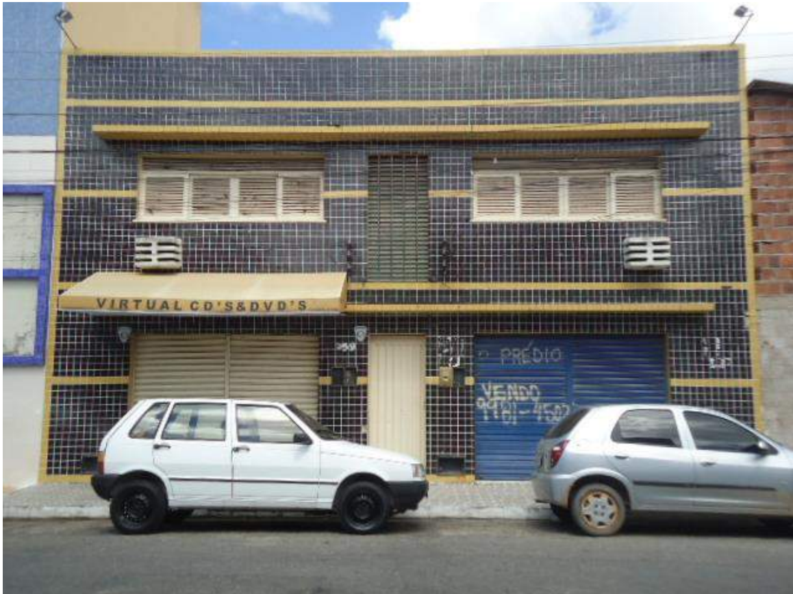
07 Prédio anexo 2 - Fachada lateral esquerda (Rua Barão de Alagoas – Centro – nº 259)
