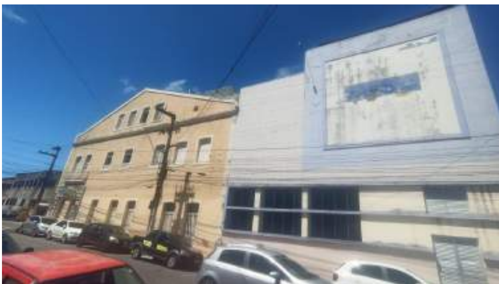
04 Fachada Lateral esquerda - 02 edificações distintas e primitivas (Rua Barão de Alagoas)
