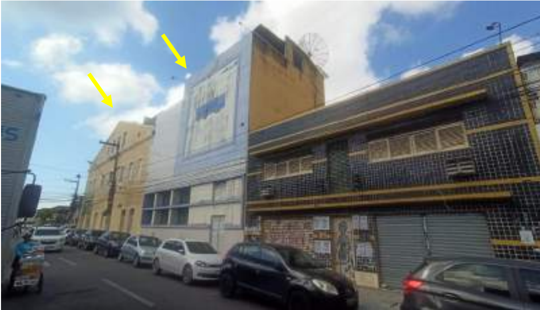
13 Prédio Principal (edificações primitivas) – Fachada lateral esquerda (Rua Barão de Alagoas)
