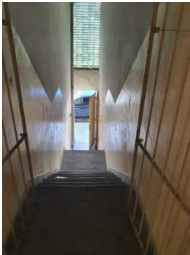
08 Prédio anexo 2 – Escada acesso pav. superior (Rua Barão de Alagoas – Centro – nº 259)
