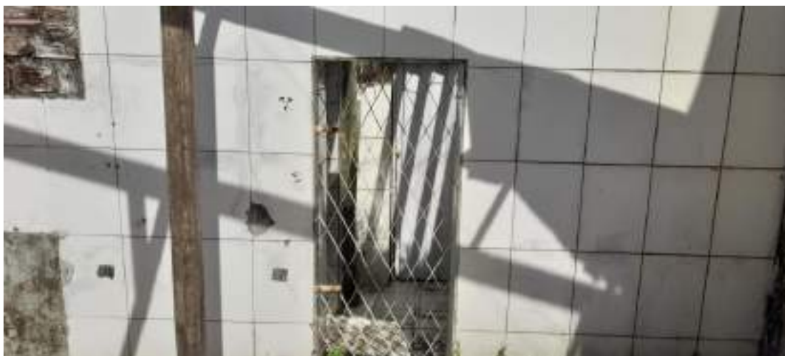
09 Prédio anexo 2 – Acesso secundário ( interno) pelo terreno posterior
