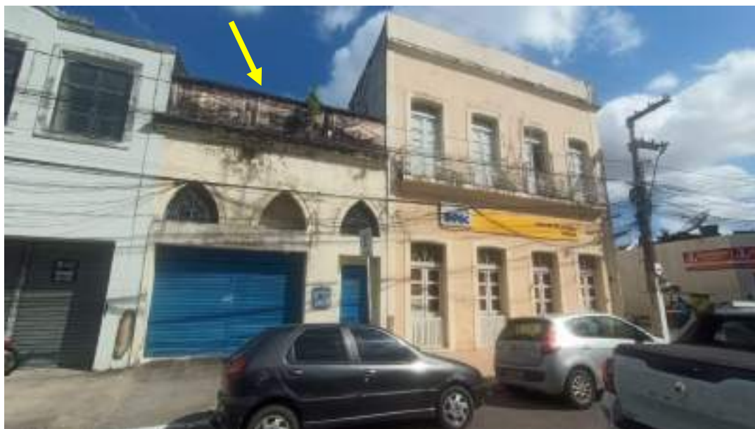
05 Prédio anexo 1 (Rua Augusta)
