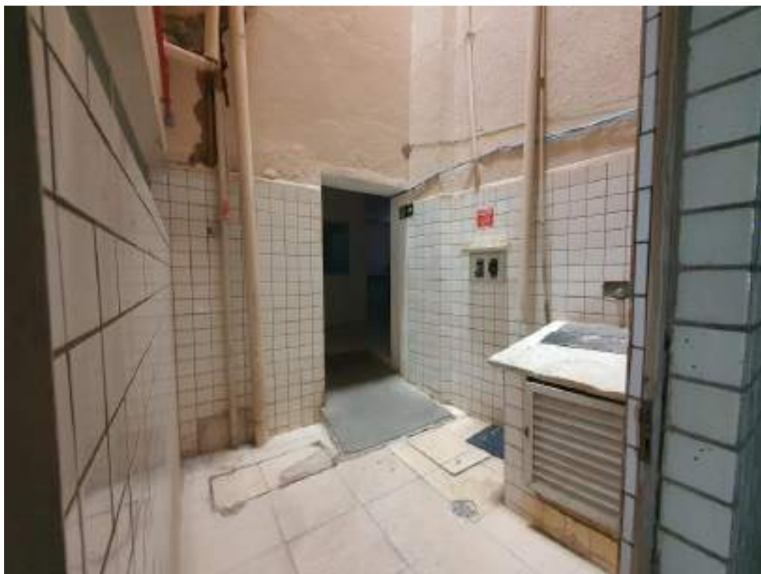
19 Acesso a cozinha, vestiários e serviço – transição para prédio anexo 1.
