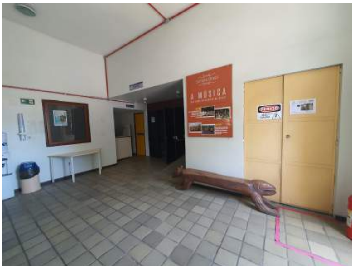
42 Circulação de acesso ao teatro e a direita subestação.
