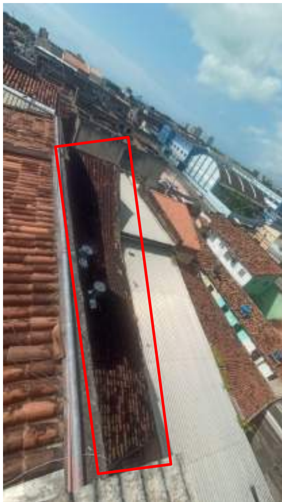
69 Prédio anexo 1 – coberta (techo posterior)
