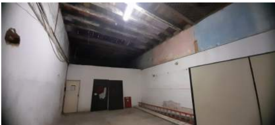
66 Prédio anexo 1 – salão frontal
