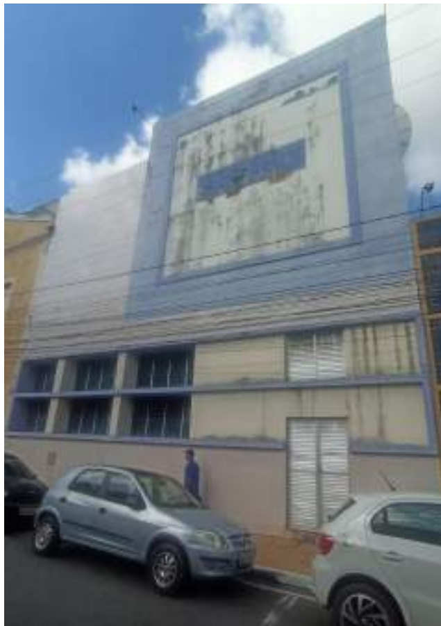
57 Edificação contemporânea agregada ao Prédio principal.
