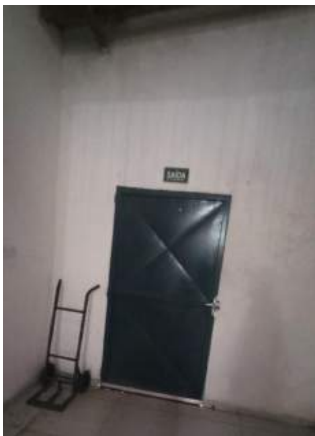
71 Ligação da unidade com o prédio anexo 2 e terreno posterior (fachada posterior do prédio anexo 1)
