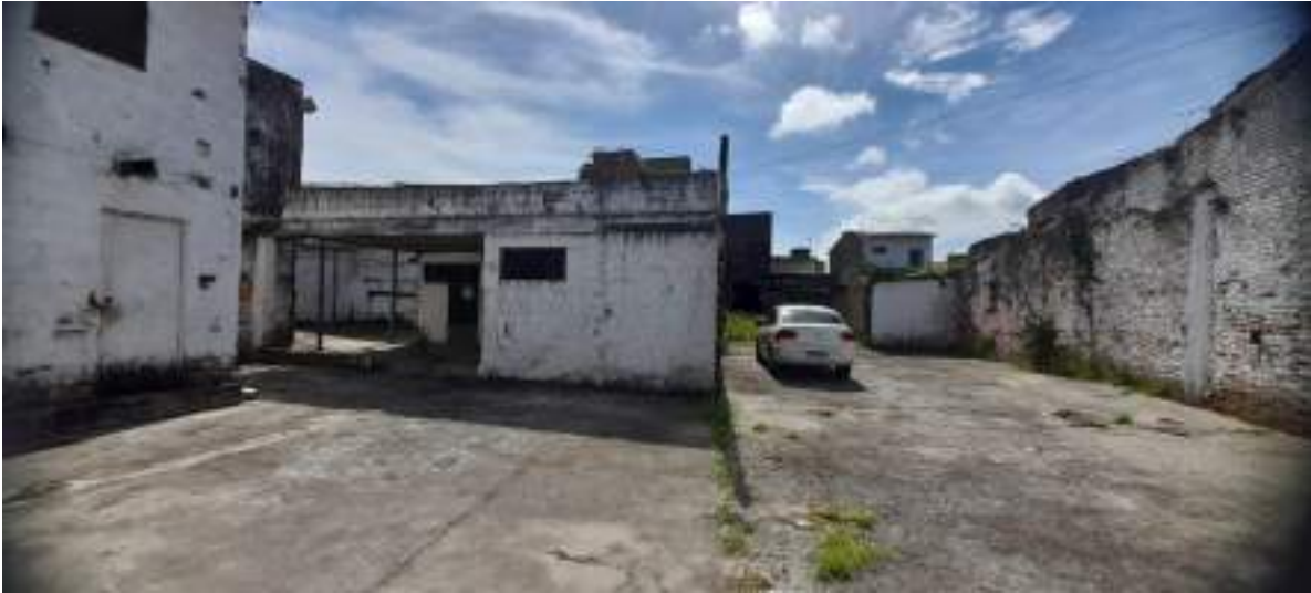
87 Terreno posterior – trecho descoberto
