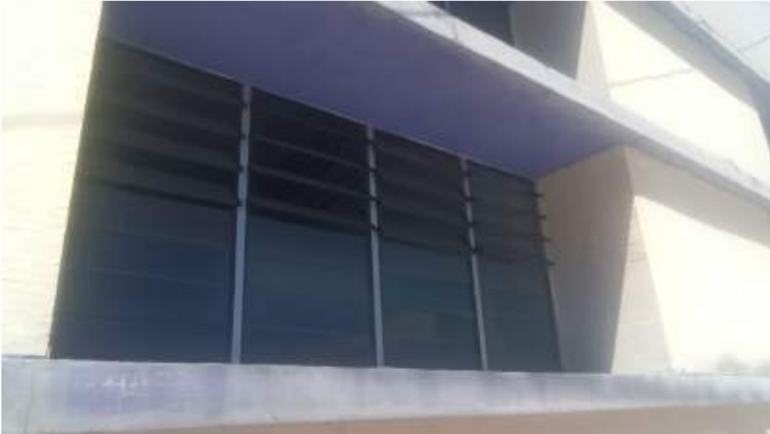
61 Fachada edificação contemporânea – Janela veneziana
