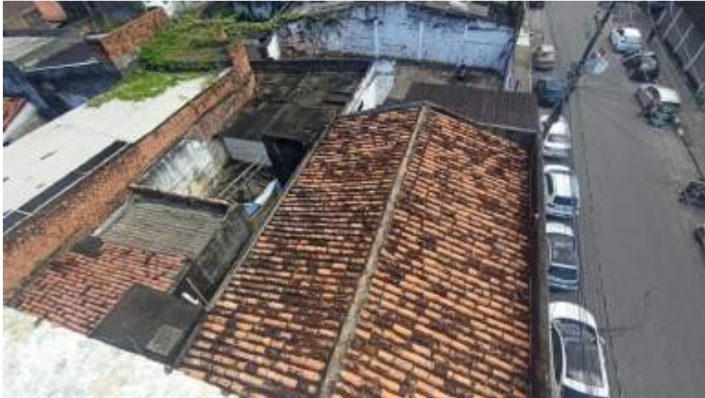
82 Prédio anexo 2 – cobertura
