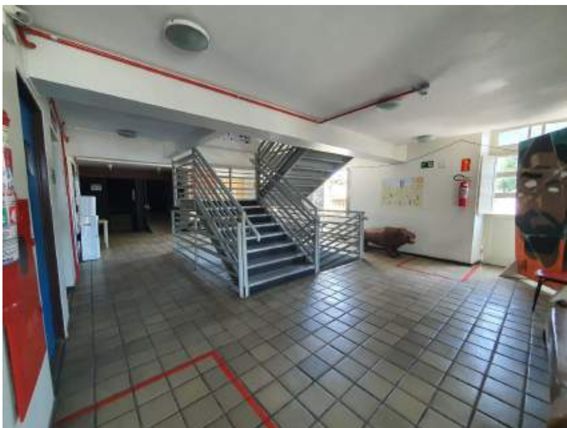
44 Escada de acesso ao segundo pavimento.
