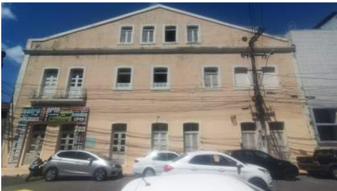
59 CobertasFachada lateral - Esquadrias
